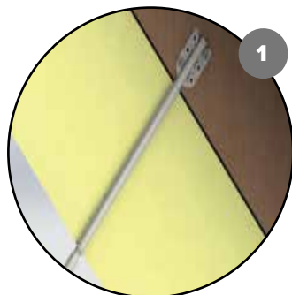
1. Fixer la suspenste sur la charpente
