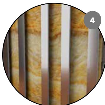
4. Pose de la fourrrue
