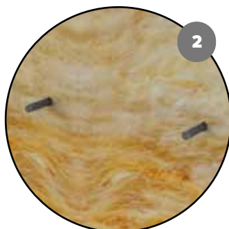
2. Pose de la laine
